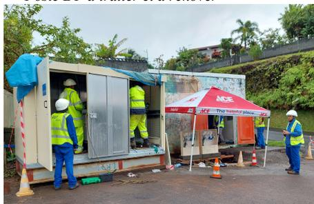
*Transfert des équipements électriques au poste provisoire*
