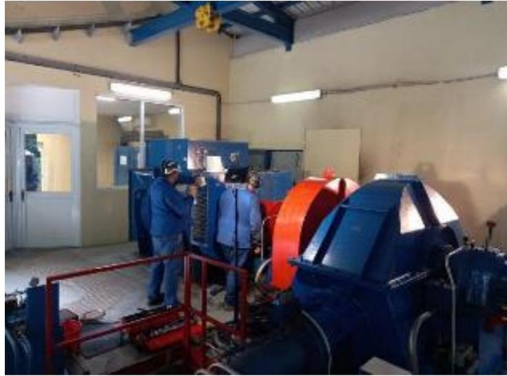
Sur Fa'atauti'a 1, une mission de General Electric Renewable Energy a été organisée dans le but d'effectuer un contrôle voire une optimisation des réglages des régulateurs de vitesse TSLG des centrales afin de réduire les oscillations produites sur le réseau quand la production est assurée majoritairement par les centrales hydro électriques :
