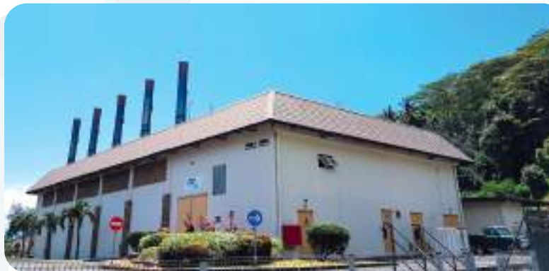
Centrale John Teariki de Moorea (© EDT Engie)
