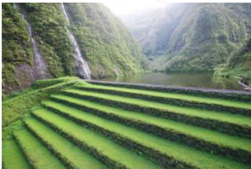
Installation hydroélectrique de la Titaaviri
