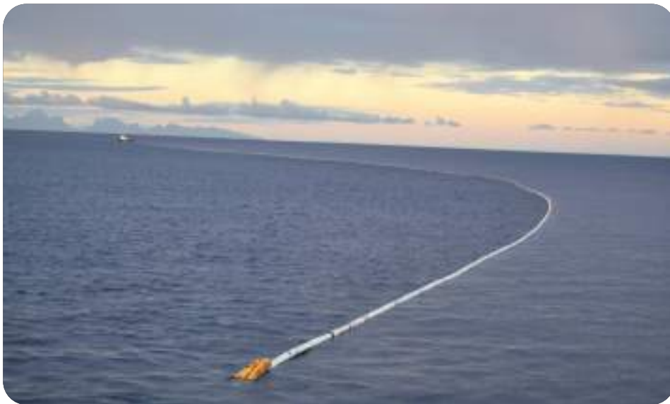
Illustration de l'installation de SWAC de Tetiaroa (© David Wary - Airaro)
