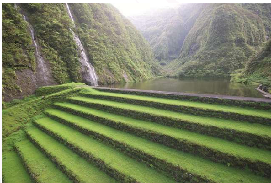
Installation hydroélectrique de la Titaaviri
