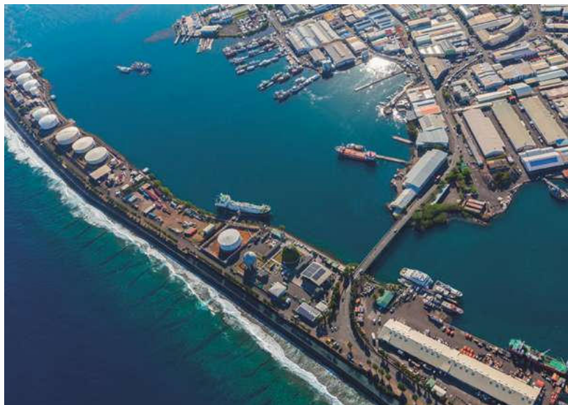
Installations de stockage d'hydrocarbures de Motu Uta (© Matarai - SDGPL)
