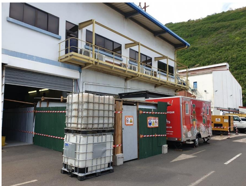
Désamiantage des vestiaires du bâtiment élec
