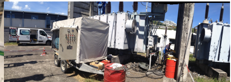
Régénération de l'huile diélectrique d'un transformateur
