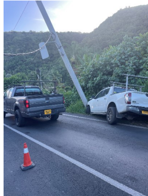
Accident sur le réseau HTA aérien causé par un tiers
