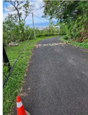
Réseau aérien BT a terre suite chutes d'arbres
