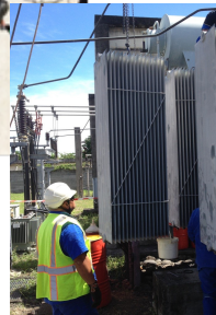
Régénération de l'huile diélectrique d'un transformateur
