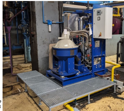
Mise en place nouvelle centrifugeuse HLM de type AlfaLaval modèle S956
