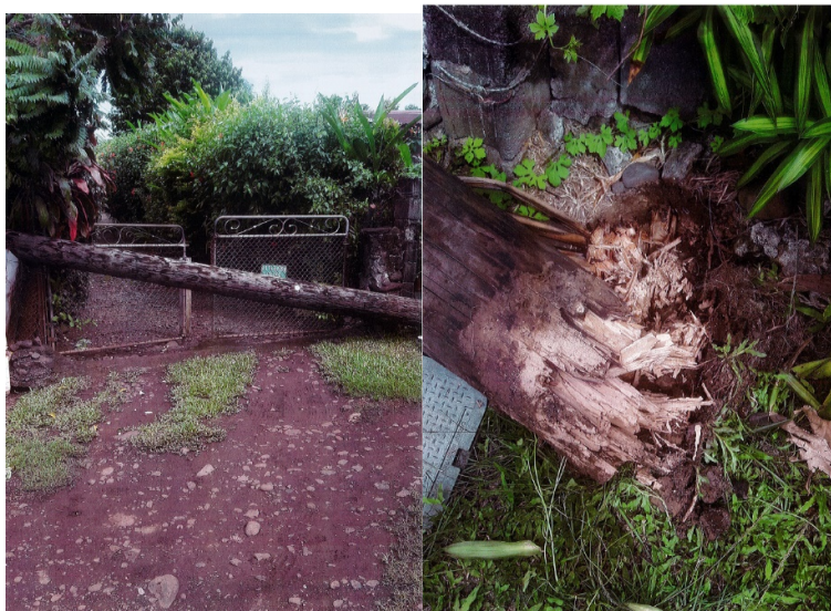
Poteau BT termité à terre
