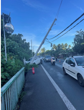
Accident sur le réseau HTA aérien causé par un tiers
