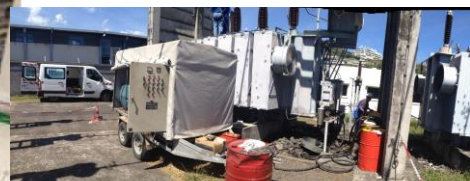
Régénération de l'huile diélectrique d'un transformateur
