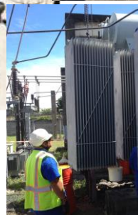
Régénération de l'huile diélectrique d'un transformateur
