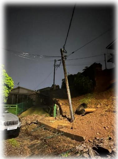
Glissement de terrain endommageant un poteau
