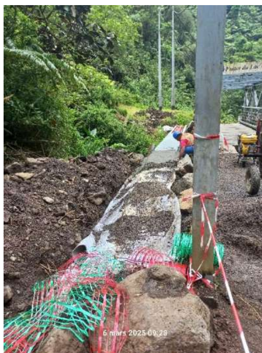
Figure 4 - Réalisation d'une structure autoportée / Passage de la rivière
