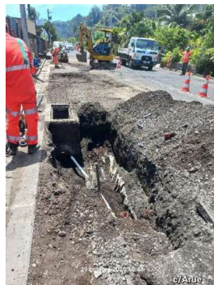
Figure 11 - Travaux de dévoiement en cours
