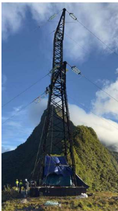
Pylône 23, remplacement chaîne d'ancrage
