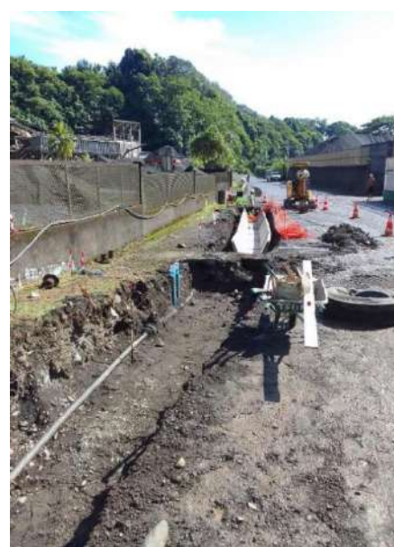
Figure 14 – Pose réseau EP en parallèle et à proximité du réseau TEP
