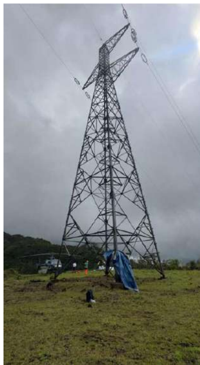
Pylône 7 Remplacement des paliers de fixations
