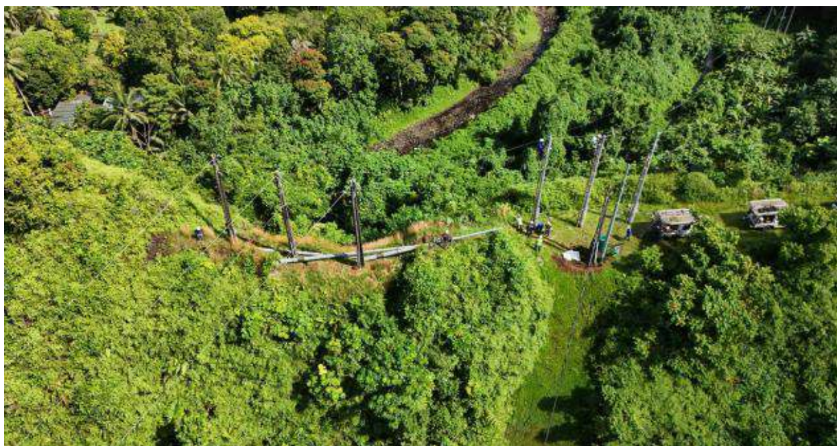
Vue aérienne du chantier de renouvellement poteaux.
