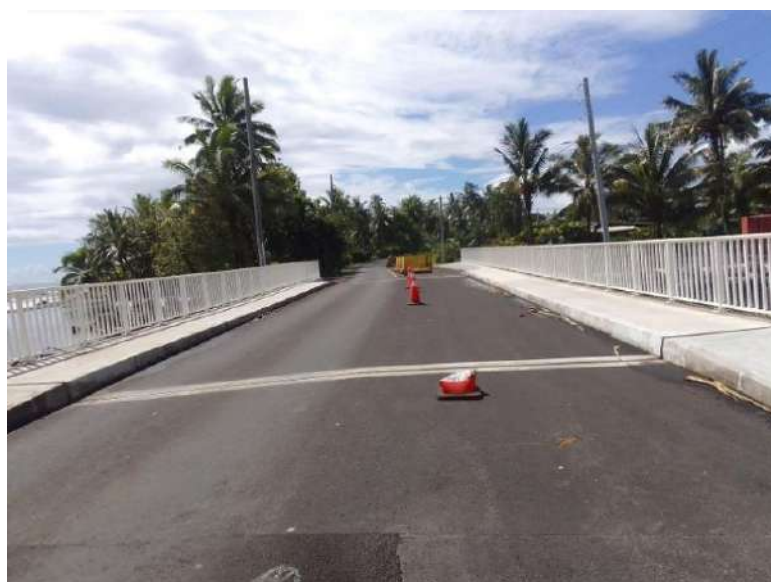
Figure 2 - Pont de la rivière VAÏAUA après travaux
