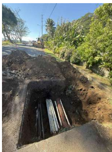
Figure 8 - Travaux de sondage des réseaux
