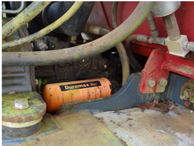
Système hydraulique sans doute défectueux.
