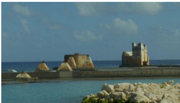
Illustration 92 : Quai de Makatea avant travaux (source ©Tahiti Nui Télévision)
