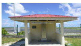
Nouvelle fontaine publique à l'aéroport de Raivavae
