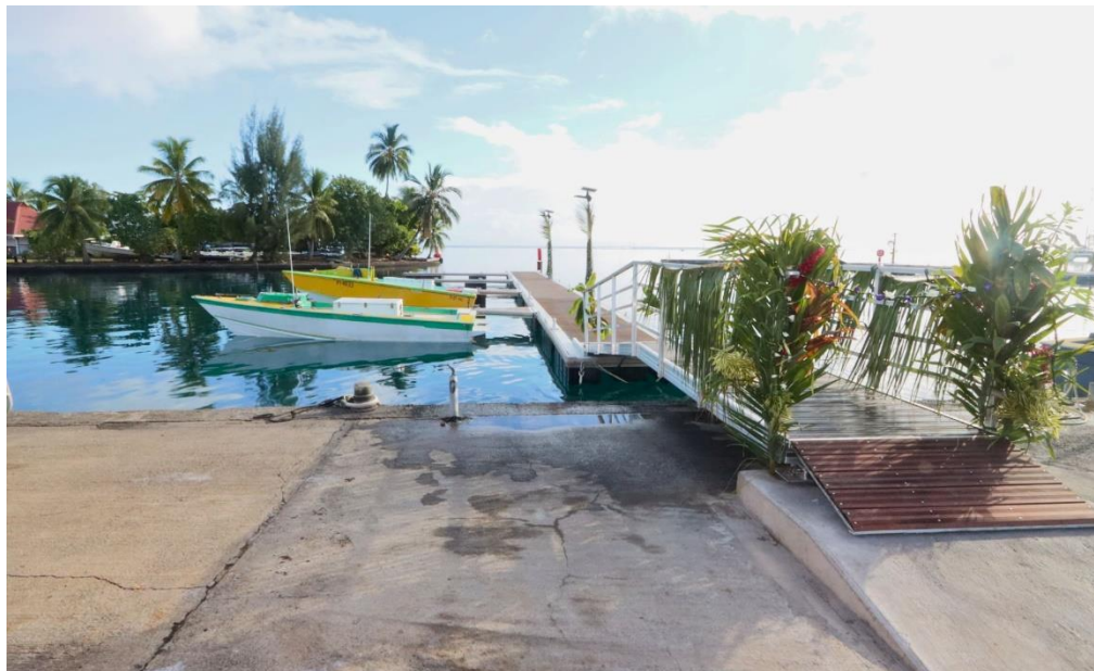
Figure 6: Livraison des pontons flottants à Arue
