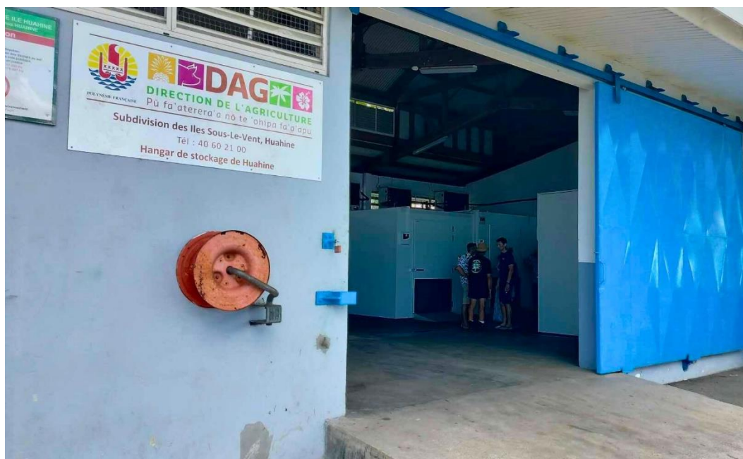
Figure 3: Hangar de stockage de Huahine réhabilité en 2024
