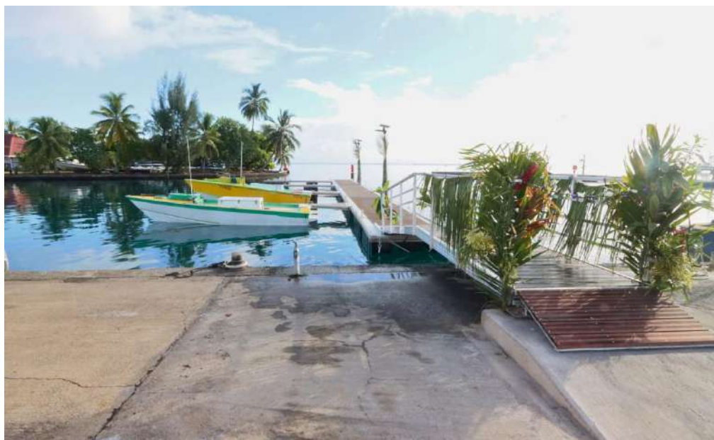
Figure 6: Livraison des pontons flottants à Arue
