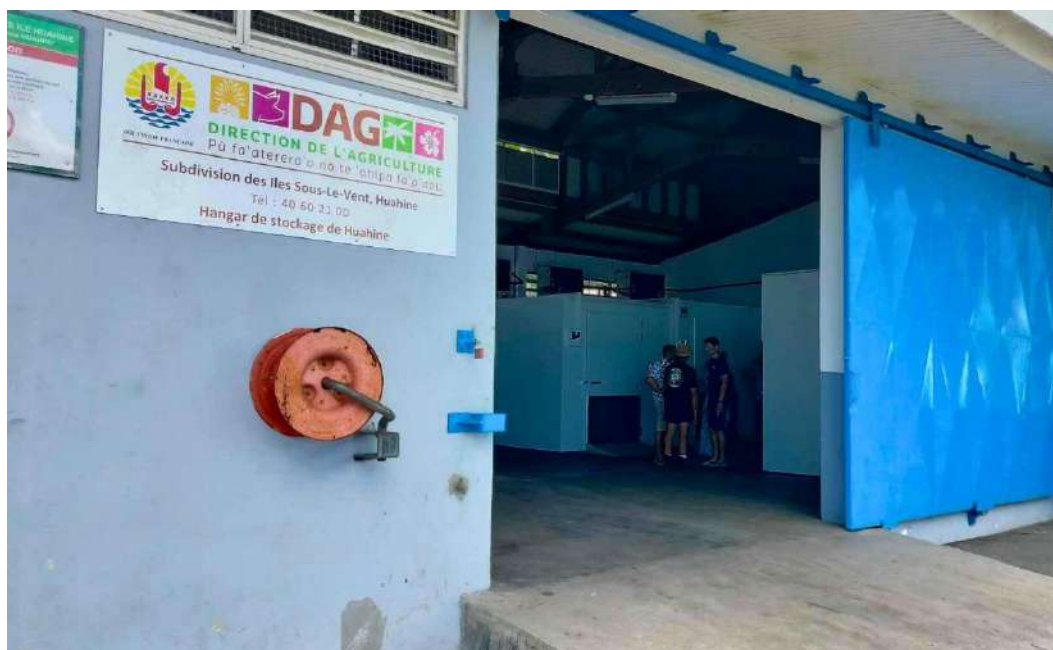
Figure 3: Hangar de stockage de Huahine réhabilité en 2024
