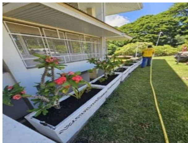
Installation de jardinières à la Direction de l'aviation civile
